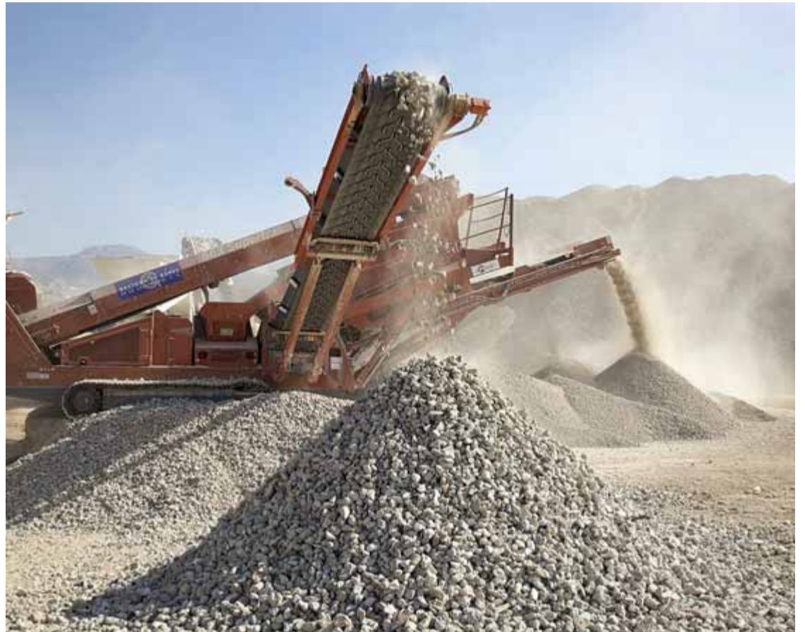
Imatge d'una de les fases de tractament de la runa, en una de les plantes de transferència de GRC. ARXIU
