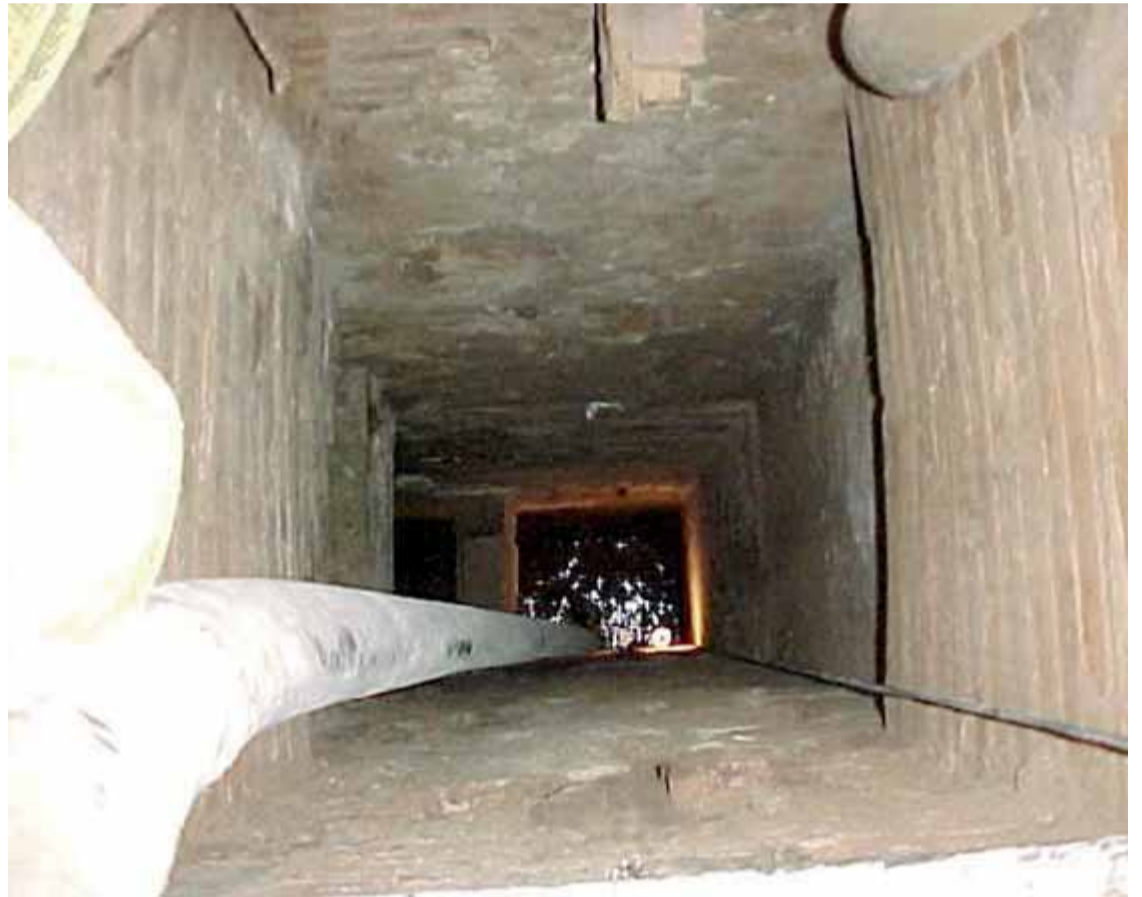
Imatge dels treballs de recuperació del pou de Can Canyadó, a Badalona. ARXIU
