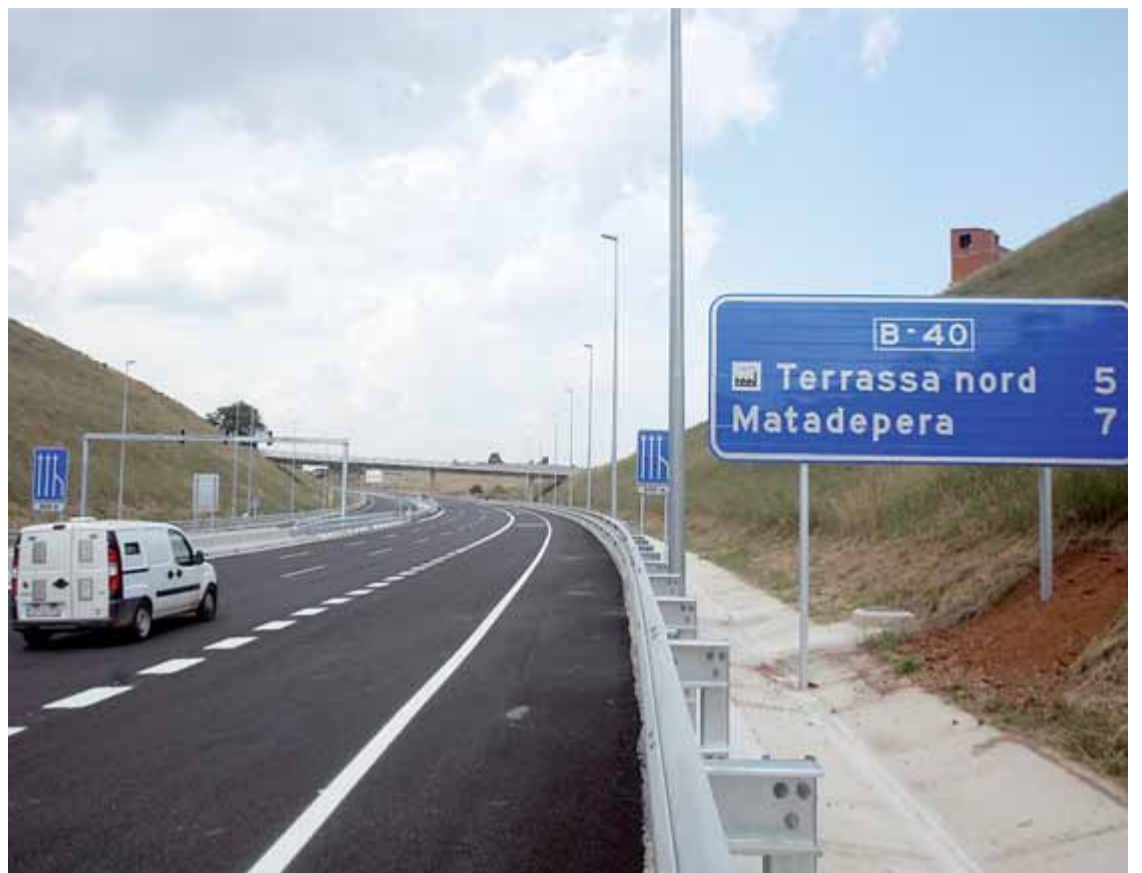
Entrada en servei del tram Viladecavalls-Terrassa del quart cinturó. ARXIU/ORIOL DURAN
