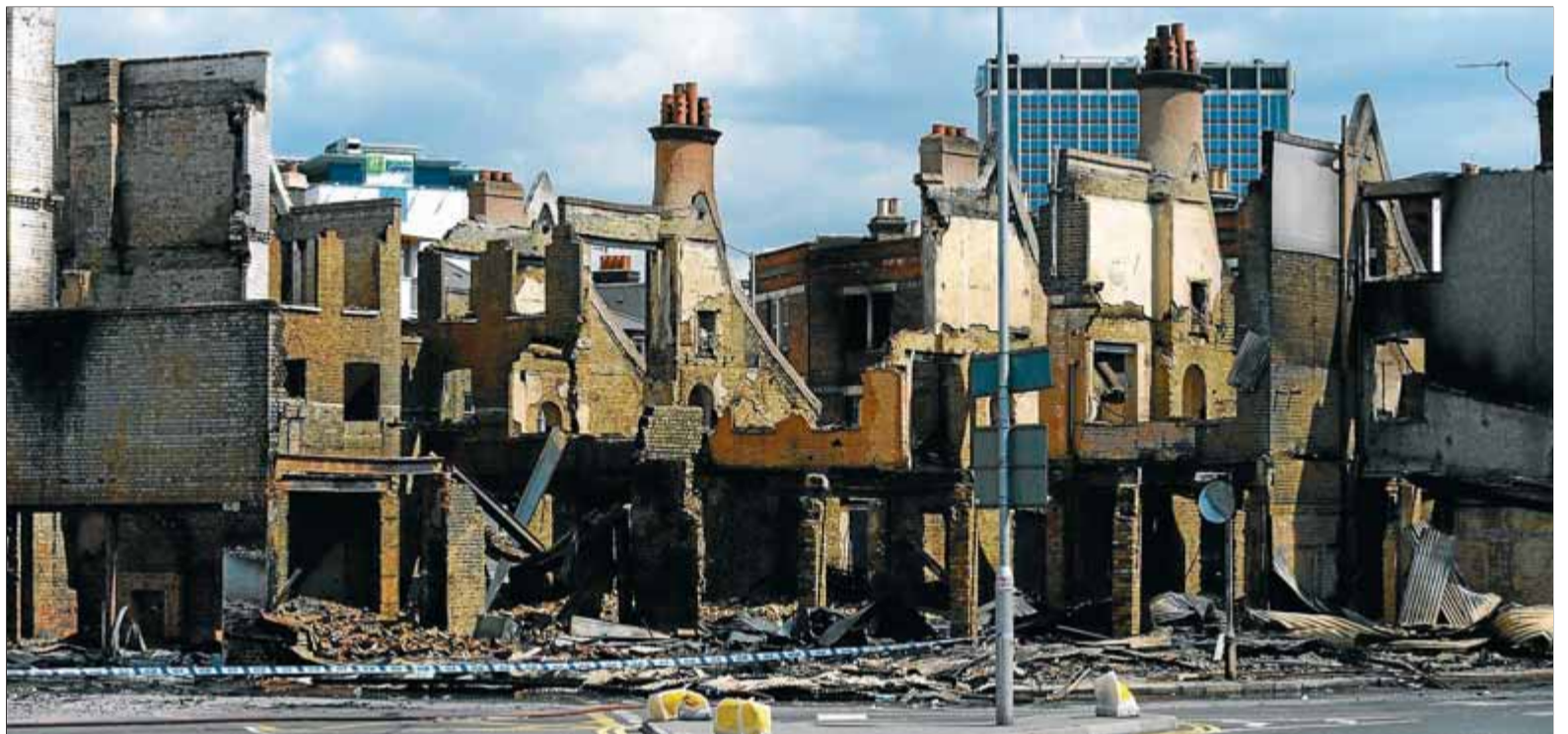
Restes d'un edifici incendiat on hi havia una botiga de mobles, al districte de Croydon, ahir a Londres ■ FACUNDO ARRIZABALAGA / EFE
