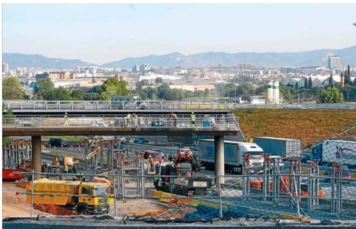
Les obres de l'enderroc del pont de Bellaterra han provocat contínues incidències viàries ■ ORIOL DURAN
