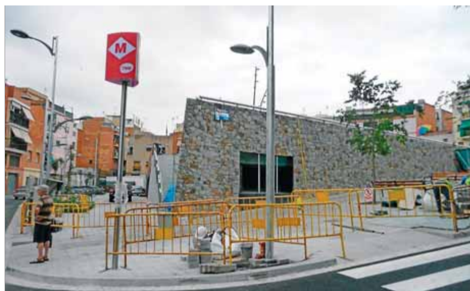
Imatge d'arxiu de l'exterior de l'estació de Santa Rosa ■ I.M.
