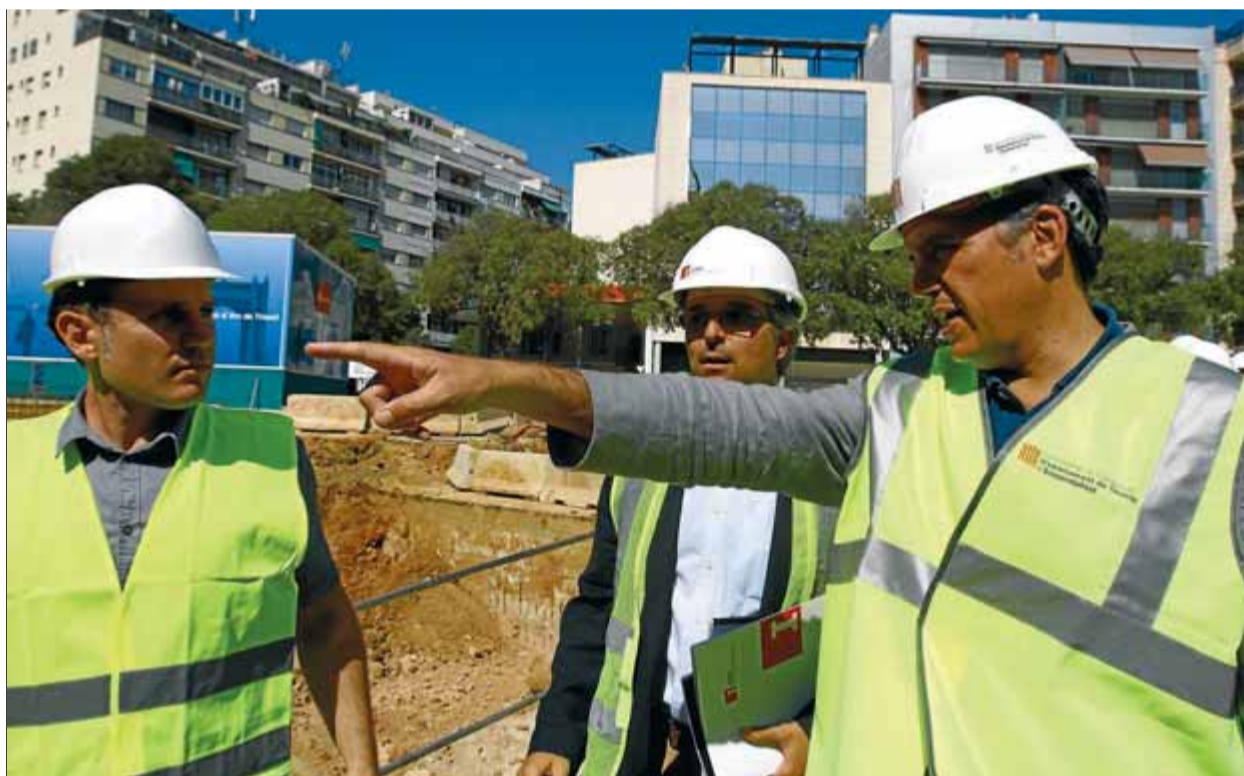
El conseller Lluís Recoder ahir durant la seva visita a les obres de l'intercanviador d'Arc de Triomf ■ ALBERT SALAMÉ
