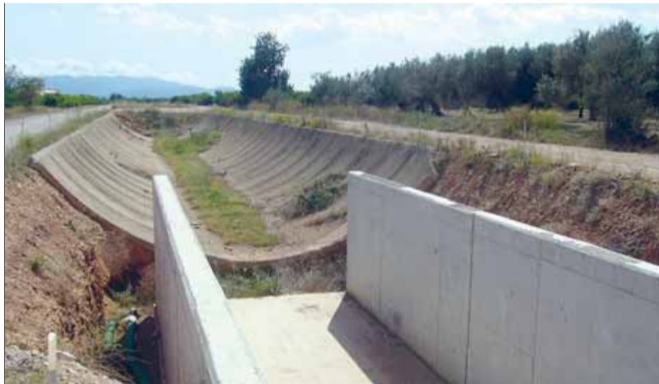
Les obres del canal Xerta-Sénia, un regadiu que segons la PDE servirà per transvasar aigua de l'Ebre a les comarques de Castelló ■ LURDES MORESO
