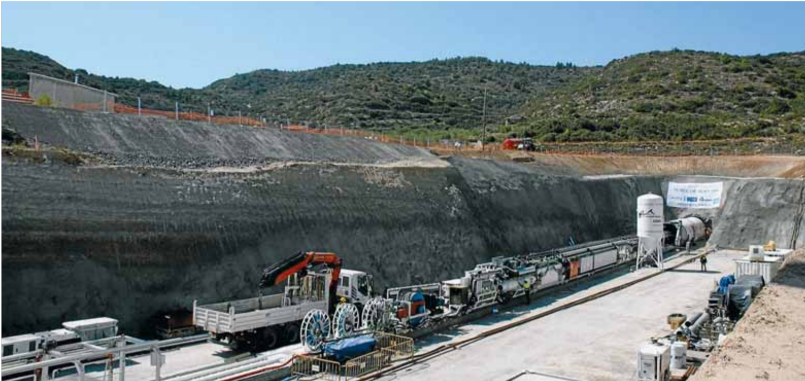
La tuneladora 'Justina', transportada des d'Alemanya i Madrid, va començar ahir els treballs, que s'acabaran a l'abril ■ ACN
