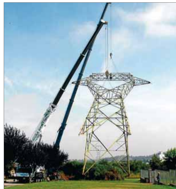
Un moment del desmuntatge de la torre propera a l'escola de Santa Eugènia de Berga, ahir ■ ACN
