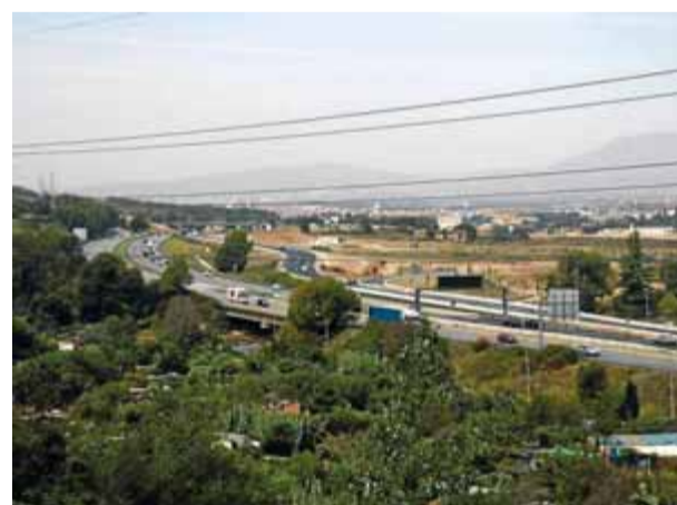
Vista de la C-58 a l'altura de Bellaterra, amb la nova calçada lateral d'accés a Sabadell Sud al fons ■ EMILI AGULLÓ
