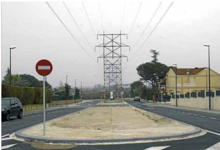
Imatge de l'avinguda de les Torres a la urbanització El Pinar, on ara l'Ajuntament de Reus impulsarà el projecte de soterrament de la línia d'alta tensió ■ J.F.
