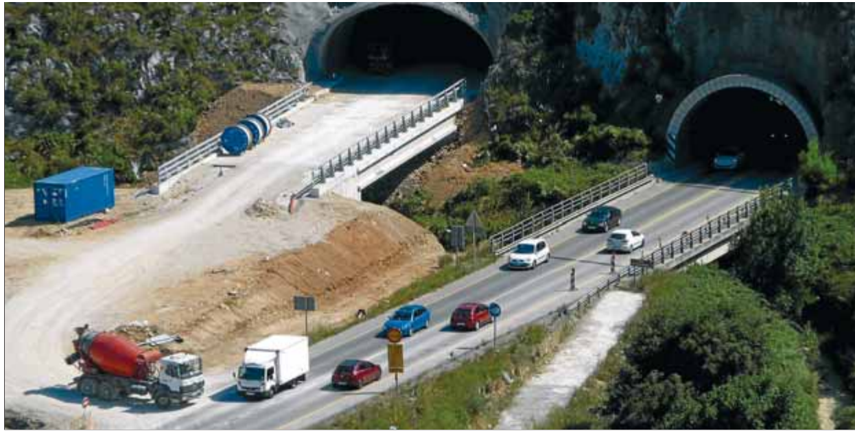
Imatge del tram del túnel d'Olèrdola de la C-15, per la qual circularan els tractors mentre no hi hagi via de servei ■ A.M.
