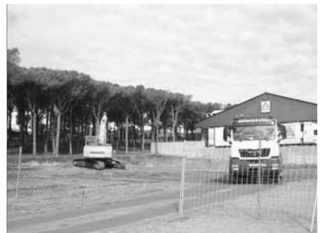
Obres de construcció de la nova gasolinera de Palafrugell, que serà de Repsol ■ A.V.
