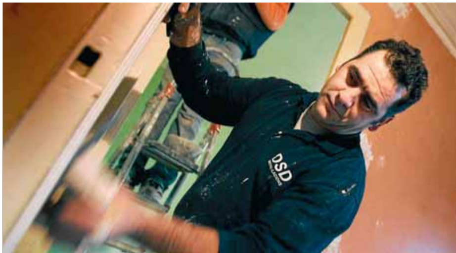
Mihita, un treballador de la construcció d'origen romanès, treballant en la rehabilitació d'una
