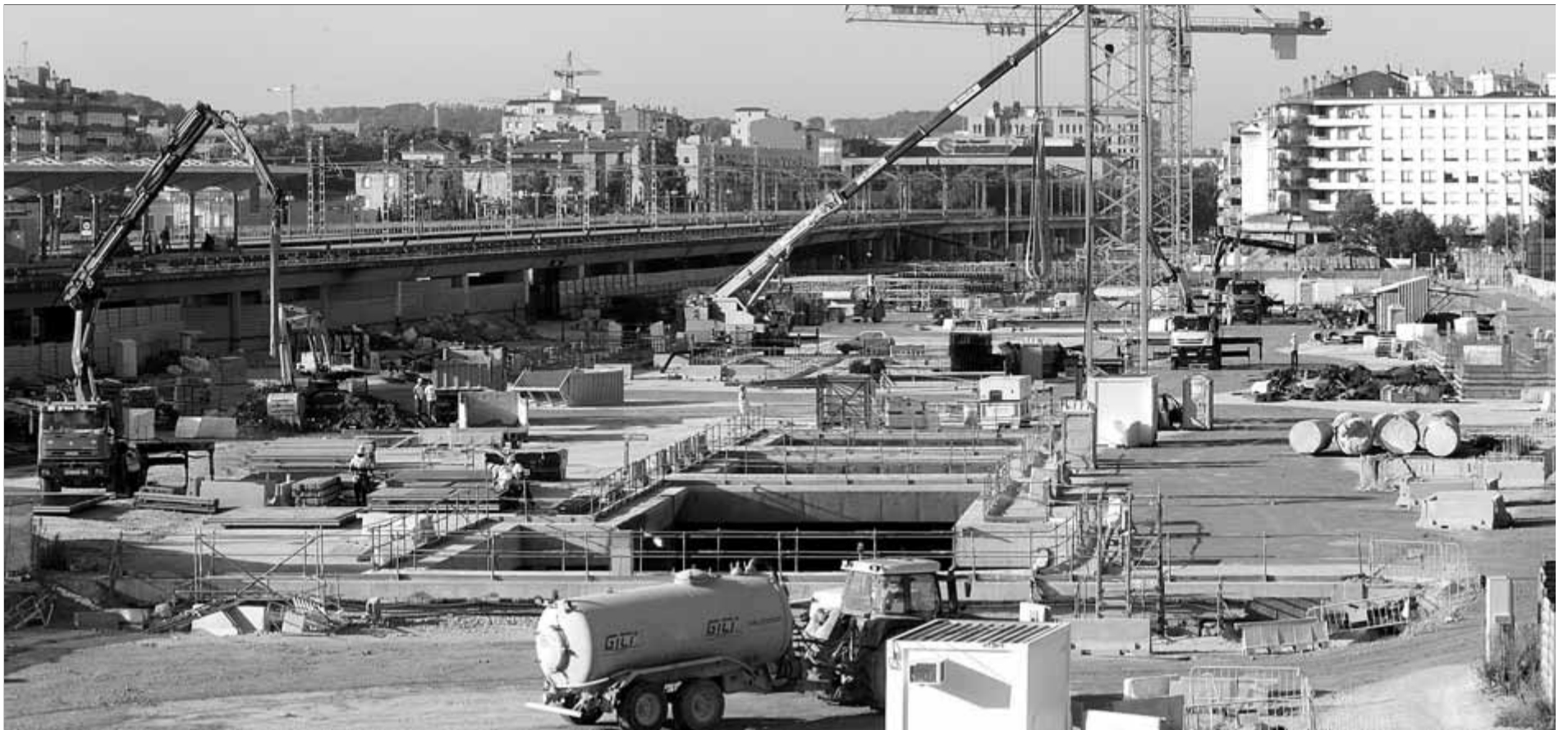
Les obres al parc Central de Girona per a la construcció de l'estació intermodal segueixen endavant tres anys després d'iniciar-se el treball al sector ■ JOAN SABATER
