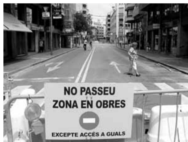
El carrer Migdia oferia ahir un aspecte insòlit, sense cotxes, per la restricció viària provocada per les obres ■ D.V.
