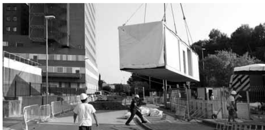
Uns operaris instal·len un dels mòduls prefabricats, on se situaran les consultes externes de l'hospital Josep Trueta, ocupant la meitat del pàrquing de Mifas ■ LLUÍS SERRAT
