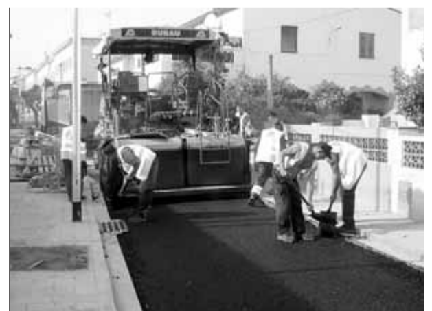
Col·locació de la primera capa de quitrà al carrer Hospital, ahir a la tarda ■ A.V.
