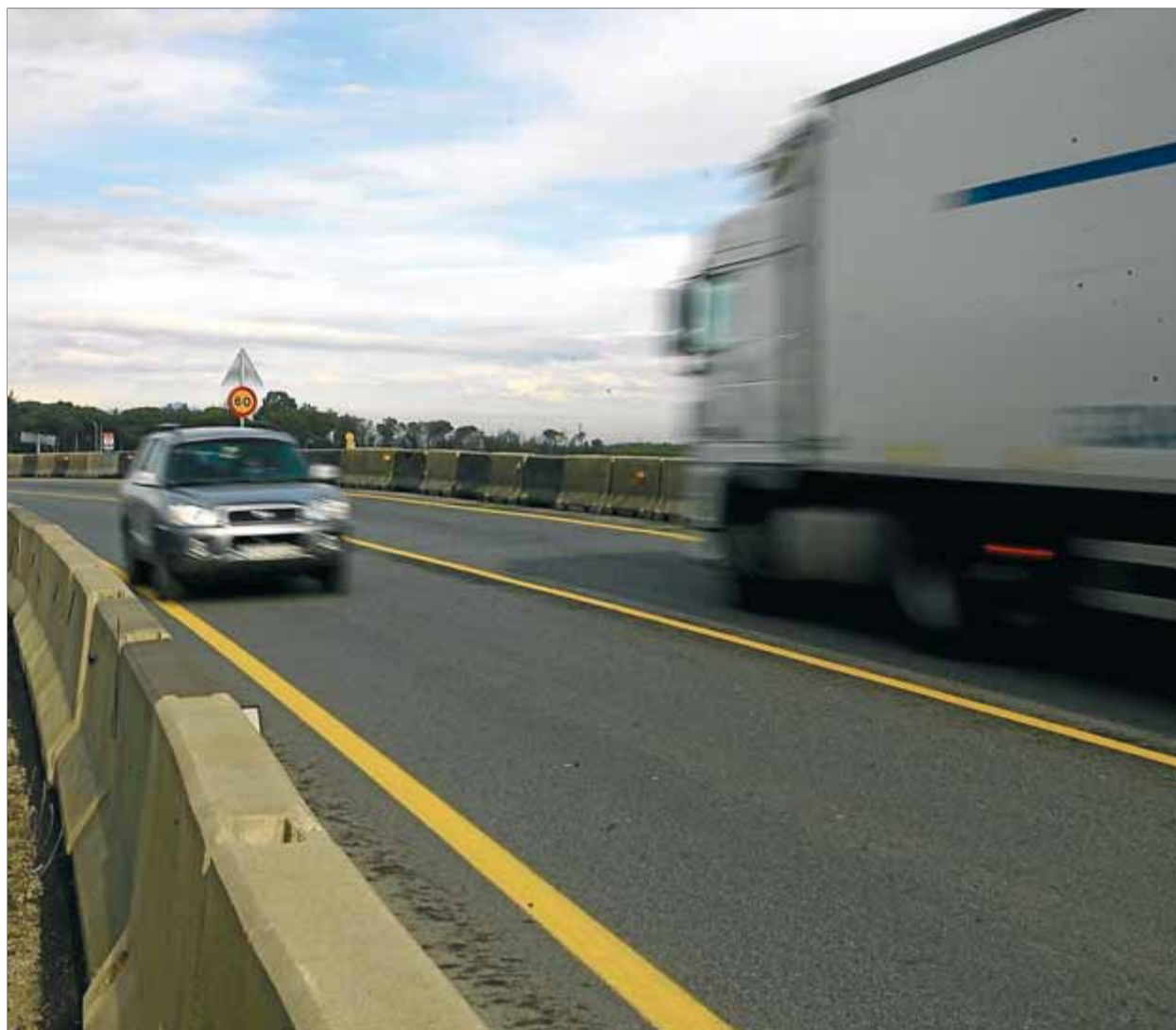
Tram de l'N-II a l'alçada de Sils, una via encara en molts trams amb un sol carril de circulació en cada sentit ■ M. LLADÓ / ARXIU
