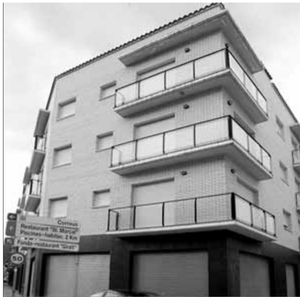
Els dos blocs d'Amer que es van construir amb una llicència mal donada l'any 2004 ■ LLUÍS SERRAT
