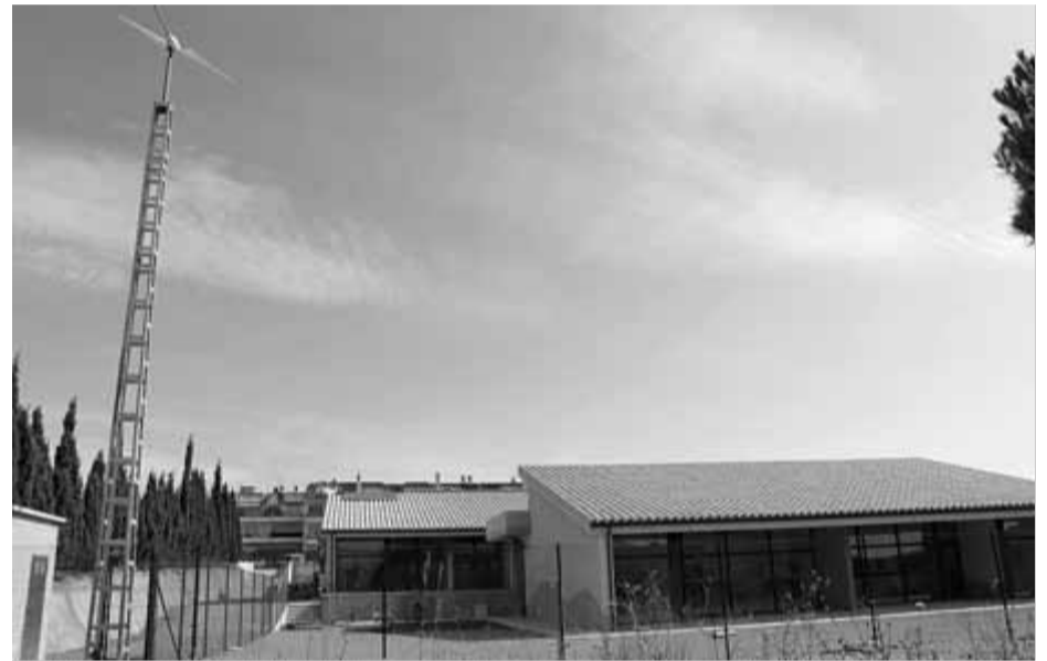
L'escola bressol inclou un aerogenerador, plaques solars i un sostre enjardinat ■ J. SABATER
