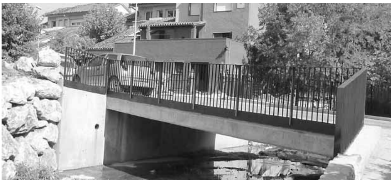
El nou viaducte, en una imatge de la setmana passada ■ R.E.
