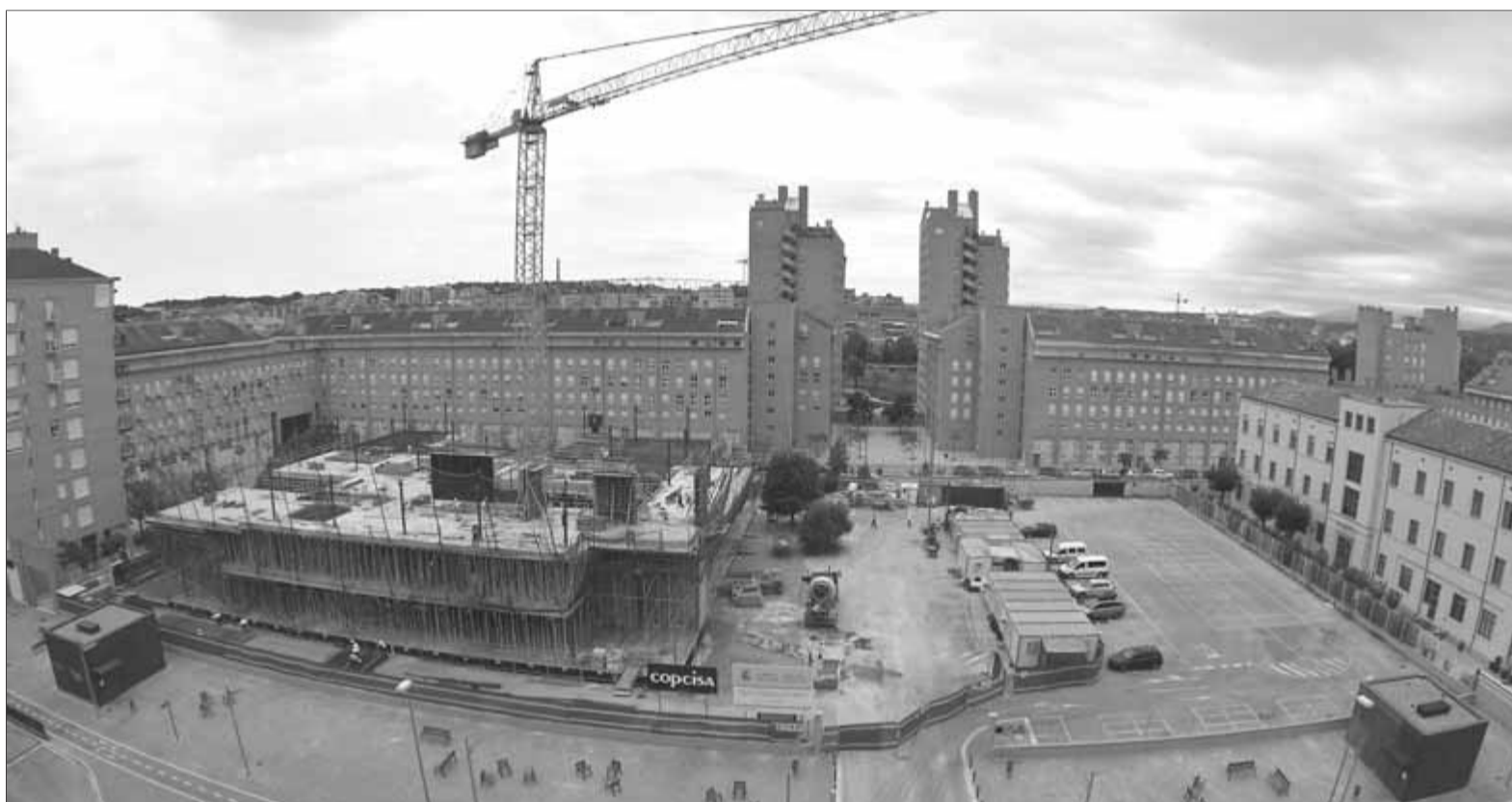
A l'esquerra, les obres de la biblioteca. A la dreta, el solar on hi havia d'anar el Bòlit i que, de moment, estarà buit els quatre propers anys ■ LL. SERRAT
