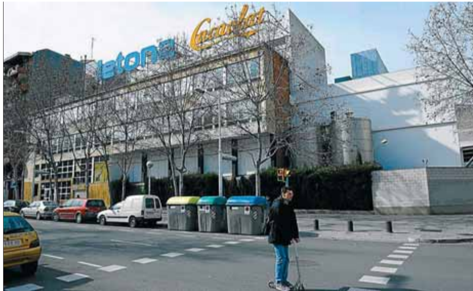
Instal·lacions de Cacaolat, al Poble Nou de Barcelona ■ JOSEP LOSADA / ARXIU
