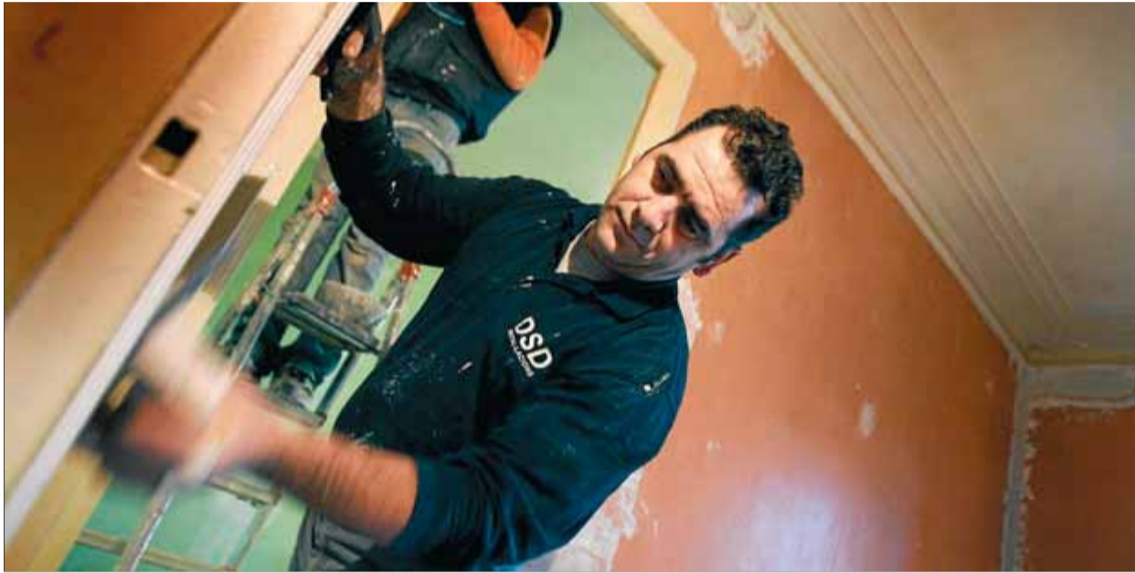
Mihita, un treballador de la construcció d'origen romanès, treballant en la rehabilitació d'una casa ■ FRANCESC MELCION / ARXIU
