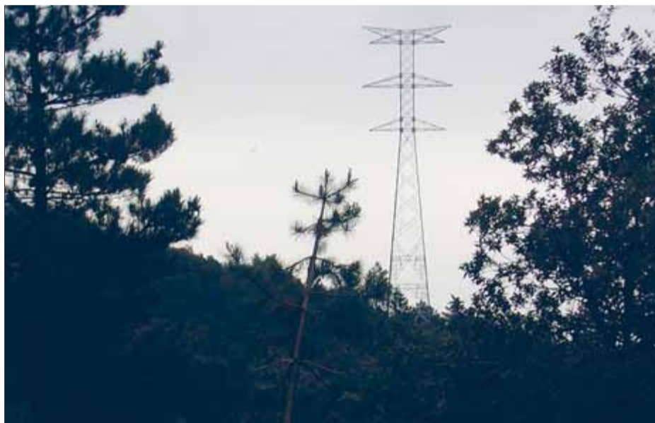
Una de les torres de la MAT a la zona de la Selva interior ■ J. COLOMER
