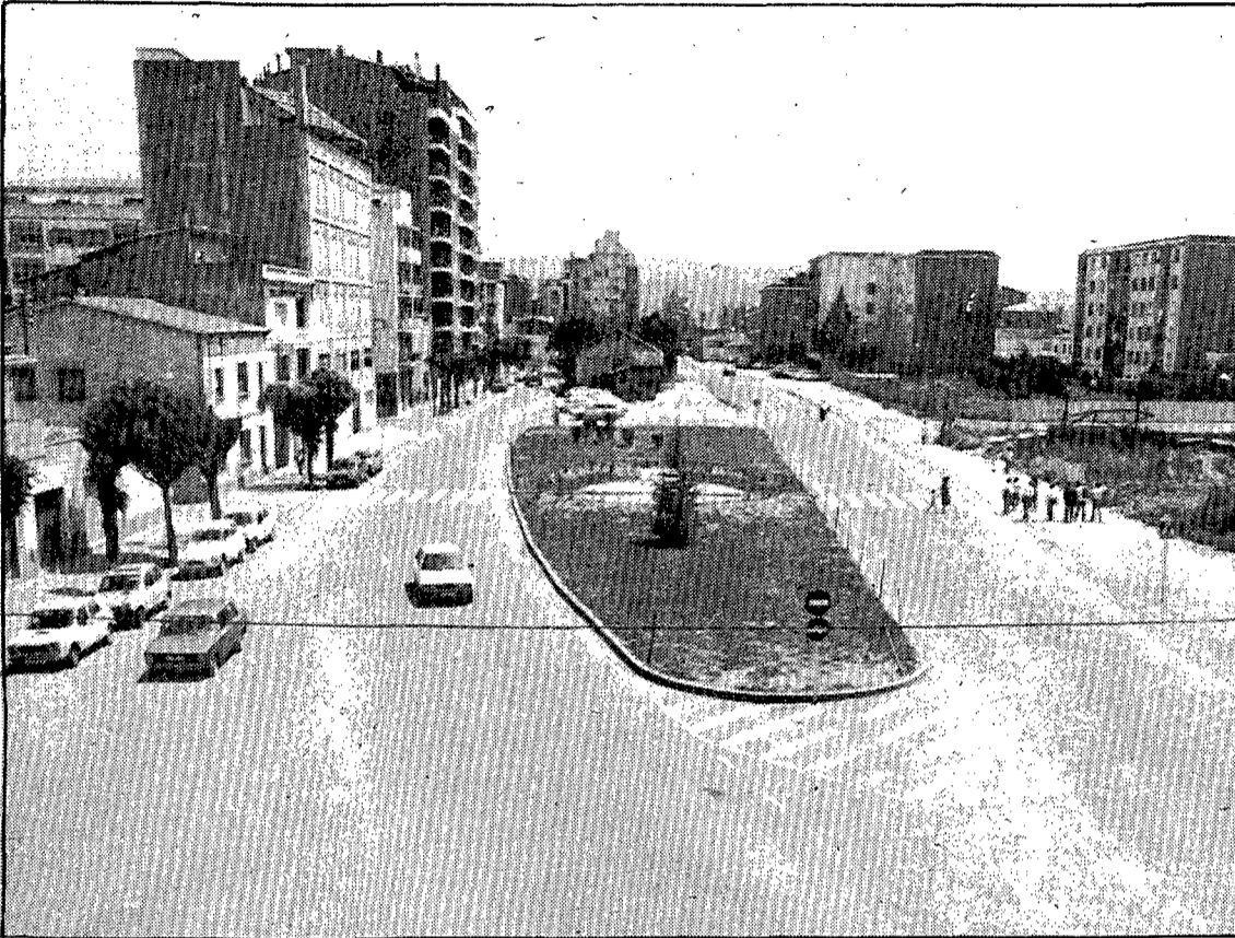
D'aquí a pocs dies començaran les obres de condicionament del passeig en la seva primera fase. (Foto DANI DUCH).
