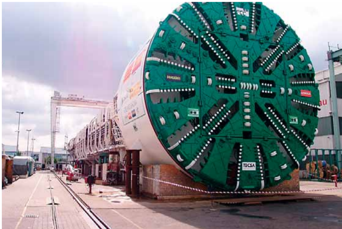
Una de les tuneladores de les obres del TAV a Catalunya. Les infraestructures són clau per al país. DAVID BRUGUÉ
