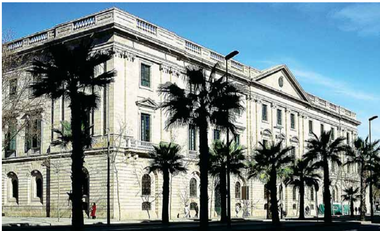
L'edifici de la Llotja de Mar, seu de la Cambra de Barcelona, institució que va formar part de la plataforma reivindicativa. ARXIU
