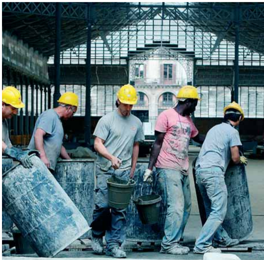
Treballadors de la construcció, al mercat del Born de Barcelona. ORIOL DURAN
