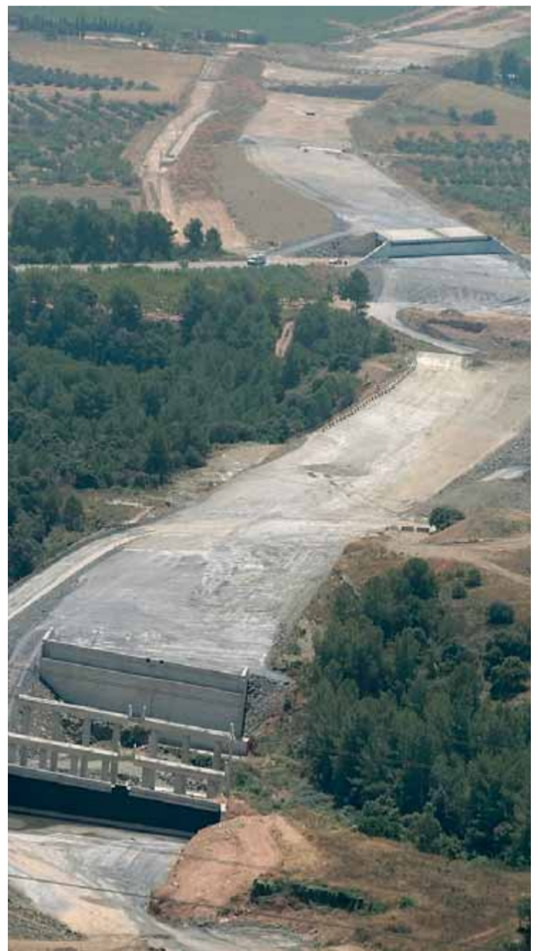
Accessos i obres de la carretera cap a Montblanc. LOLO GARCÍA
