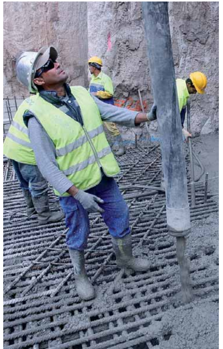
Obres del TVG entre el Prat i Barcelona. ORIOL DURAN
