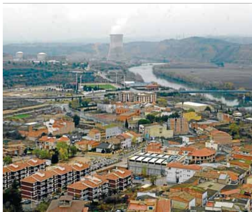
Nucli urbà d'Ascó amb els dos reactors i la torre de refrigeració de la central nuclear al fons ■ ABRAHAM SEBASTIÀ
