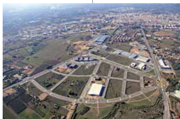
Vista aèria de Reus i, a la part inferior, el Tecnoparc.
