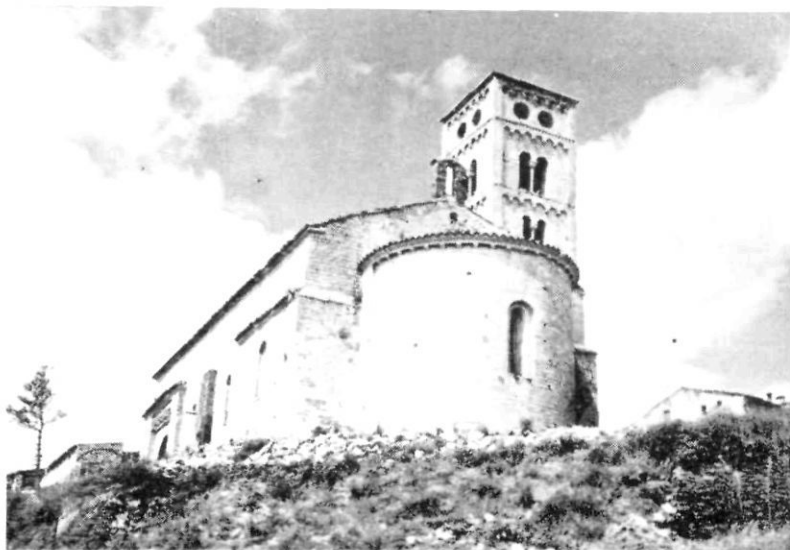
MOLLÓ - vista general después de la restauración
