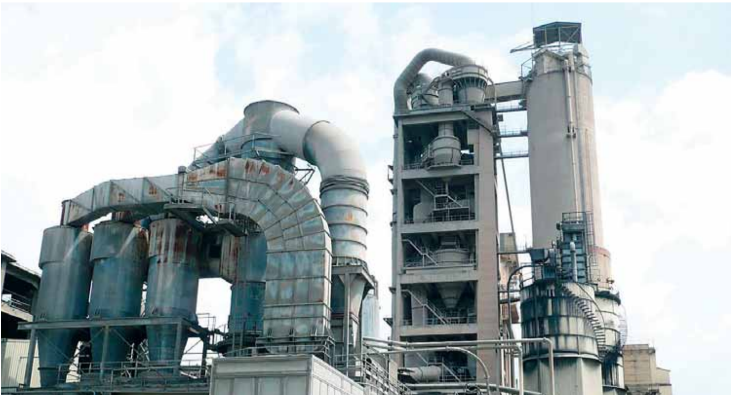
Vista de les instal·lacions de la cimentera de Lafarge, antiga Asland, a Montcada i Reixac. / CARLES ALUJU
